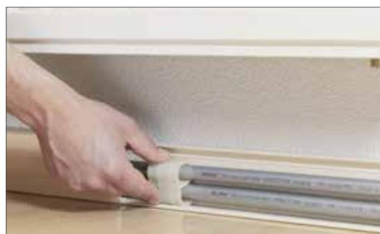
Рис.16-36 Установка фиксаторов труб отопительной разводки
