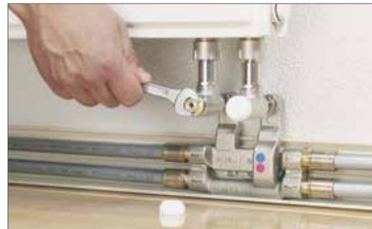
Рис. 16-38 Прочно затяните резьбозажимное соединение.
