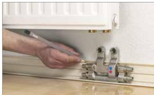
Рис. 16-32 Определение длины трубы
