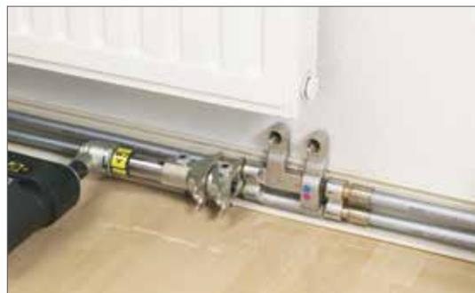
Рис. 16-33 Соединение с помощью надвижной гильзы, трубы диаметром 16 мм, с крестовиной из комплекта SL- RAUTITAN 16 - 12 - 16
