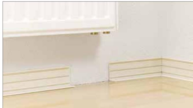
Рис. 16-42 Установленное основание плинтусного канала RAUSOLO с выемкой
