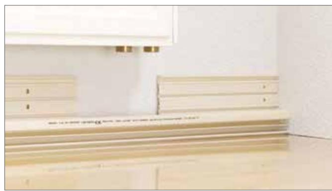
Рис.16-43 Установленное основание плинтусного канала RAUDUO с выемкой
