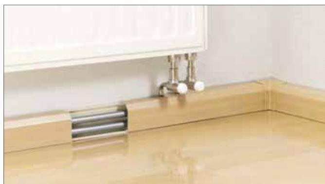
Рис. 16-44 Установленный плинтусной канал RAUSOLO с присоединительными трубками SL-RAUTITAN
