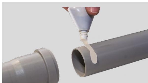
При вставке трубы на уплотнительное кольцо не должно быть смазки. Выровняйте по центру вставляемый конец трубы и до упора задвиньте в растр.
