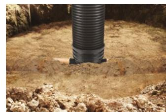
4. Удалить загрязнение с днища (кинеты). Средством для скольжения смазать изнутри днище (кинету) и уплотнение на подъёмной трубе, и установить трубу в раструбе днища (кинеты). Подготовленную таким образом днище (кинету) засыпать легко уплотняемым грунтом. Одноразовый слой насыпи не может превысить 30 см.
