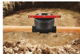
2. Установить днище (кинету) на дне траншеи (помня о проверке уровня и наклона дна на уровне 1,5%), присоединить к нему канализационные трубы, а затем засыпать ее прибл. на 10см выше уровня трубы, чтобы предотвратить перемещение днища (кинеты).
